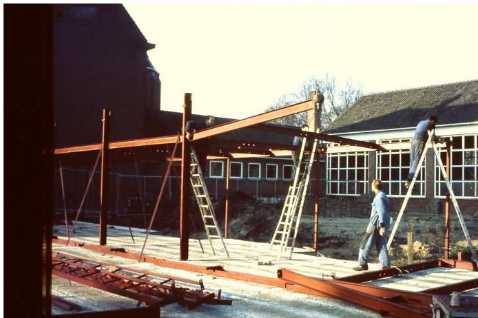
Aeresteijn in aanbouw
